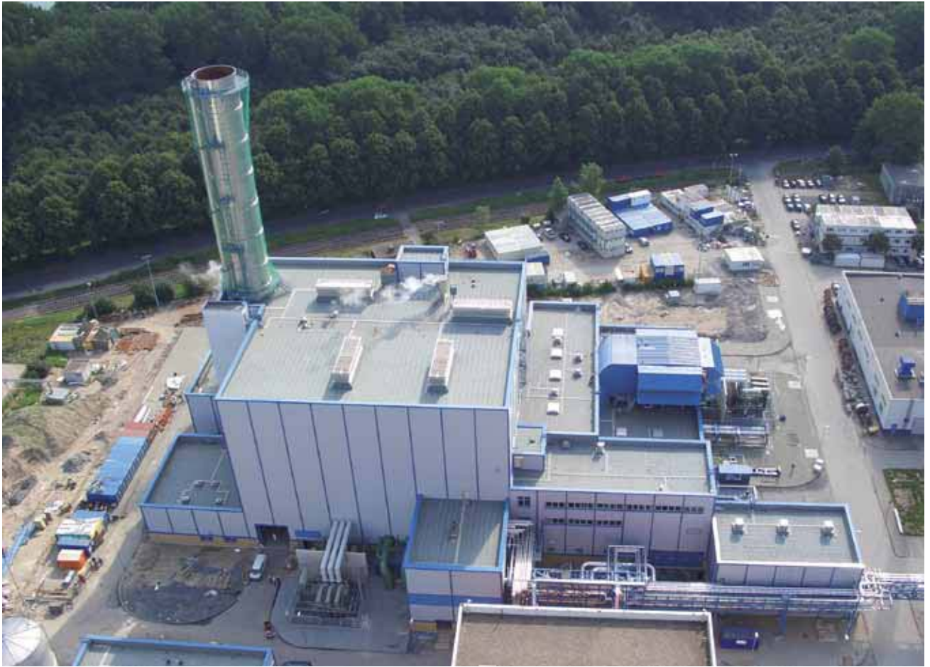
Heizkraftwerk Niehl der RheinEnergie im Norden Kölns.
